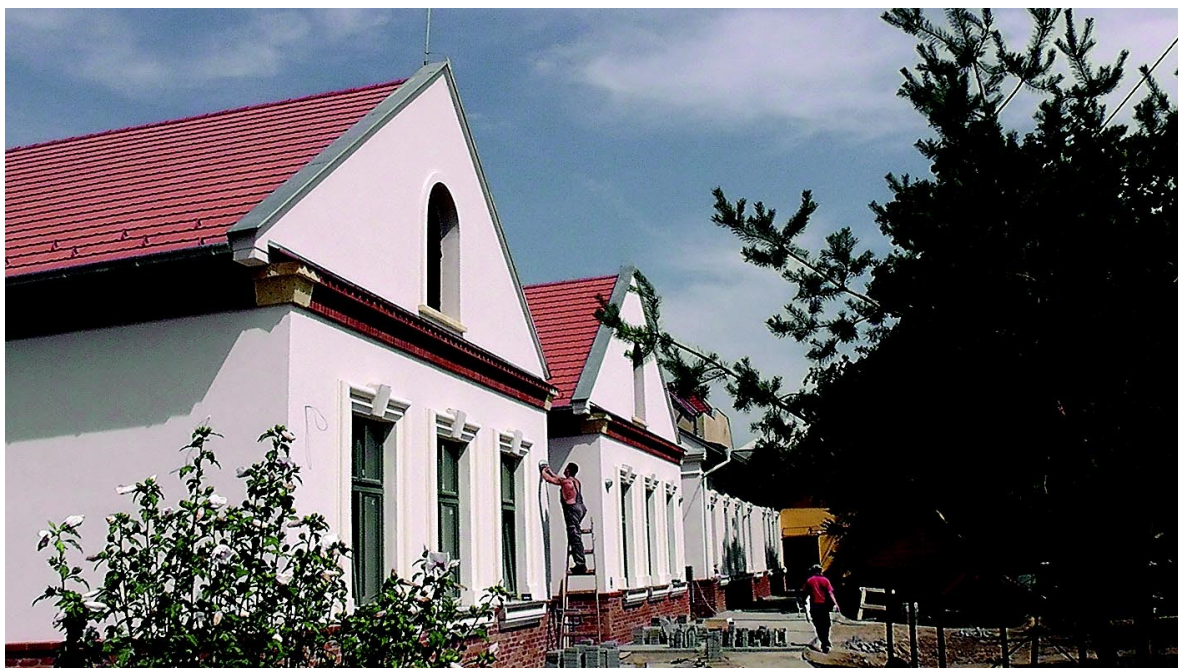
A Bethánia óvoda épülete
